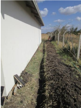
Figura 4 - Scavo e posa tubi
