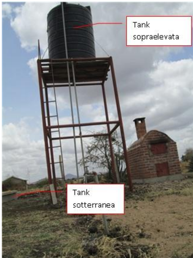
Figura 2 - Tank sotterranea e sopraelevata
